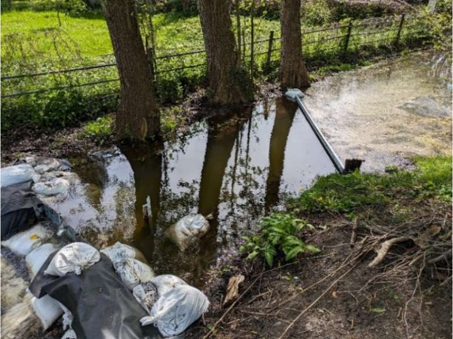
Sohlschwelle am Caputher Graben 14
